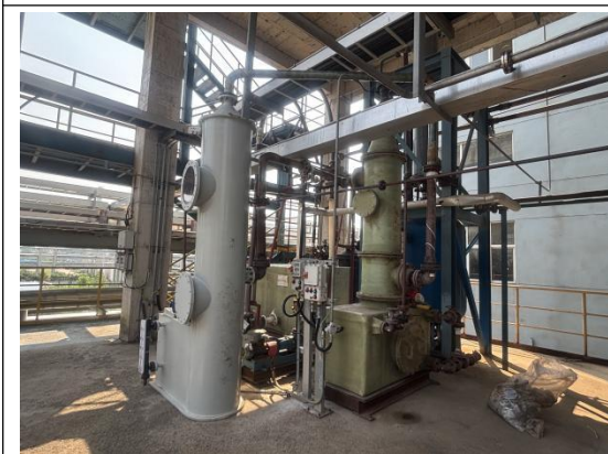
SBM 酸性废气预处理设施（二级碱喷淋，以新带老措施）
