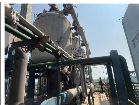
SBM 工艺废气处理设施（二级活性炭吸附-脱附罐）
