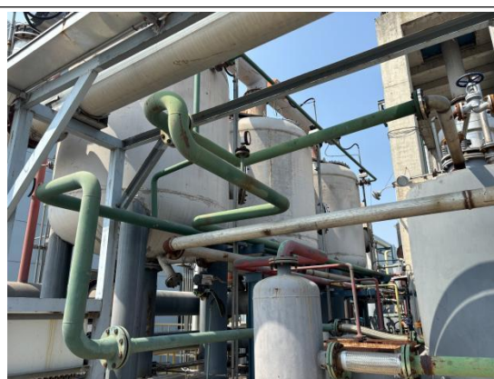
SBM 工艺废气处理设施（二级活性炭吸附-脱附罐）
