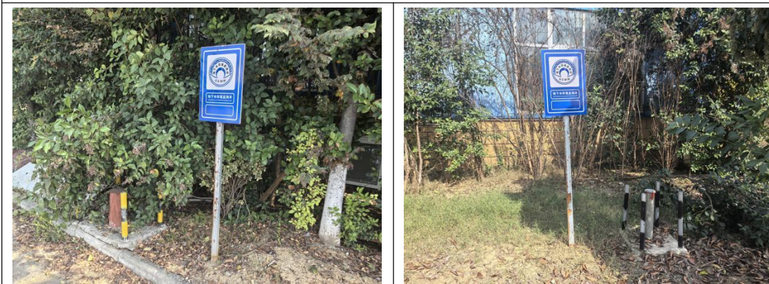
地下水监测井及标志牌
